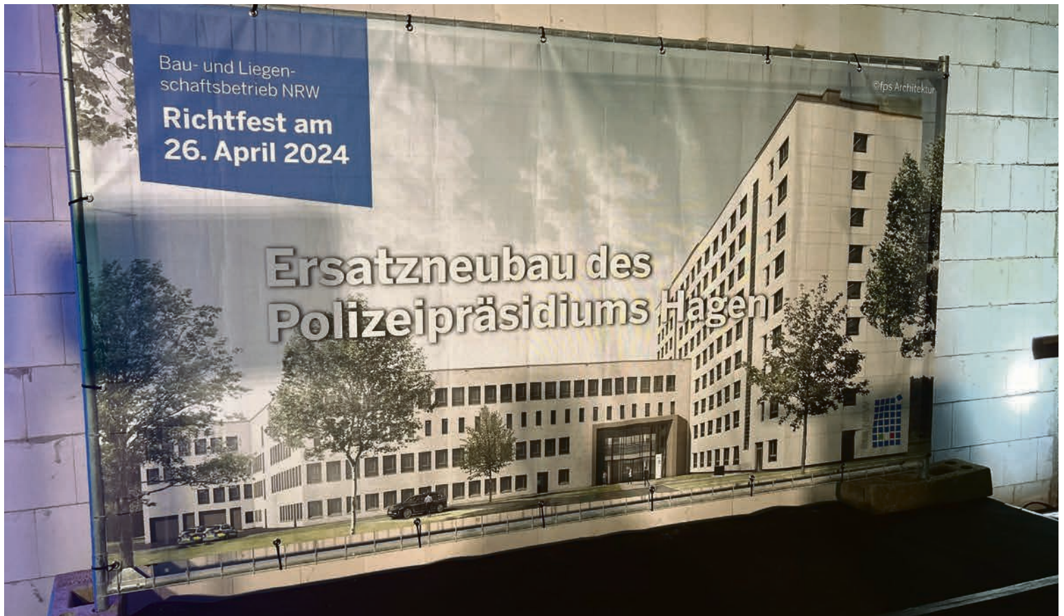
Am 26. April 2024 wurde an der Hoheleye im feierlichen Rahmen das Richtfest für den Rohbau des neuen Polizeipräsidioms gefeiert.
