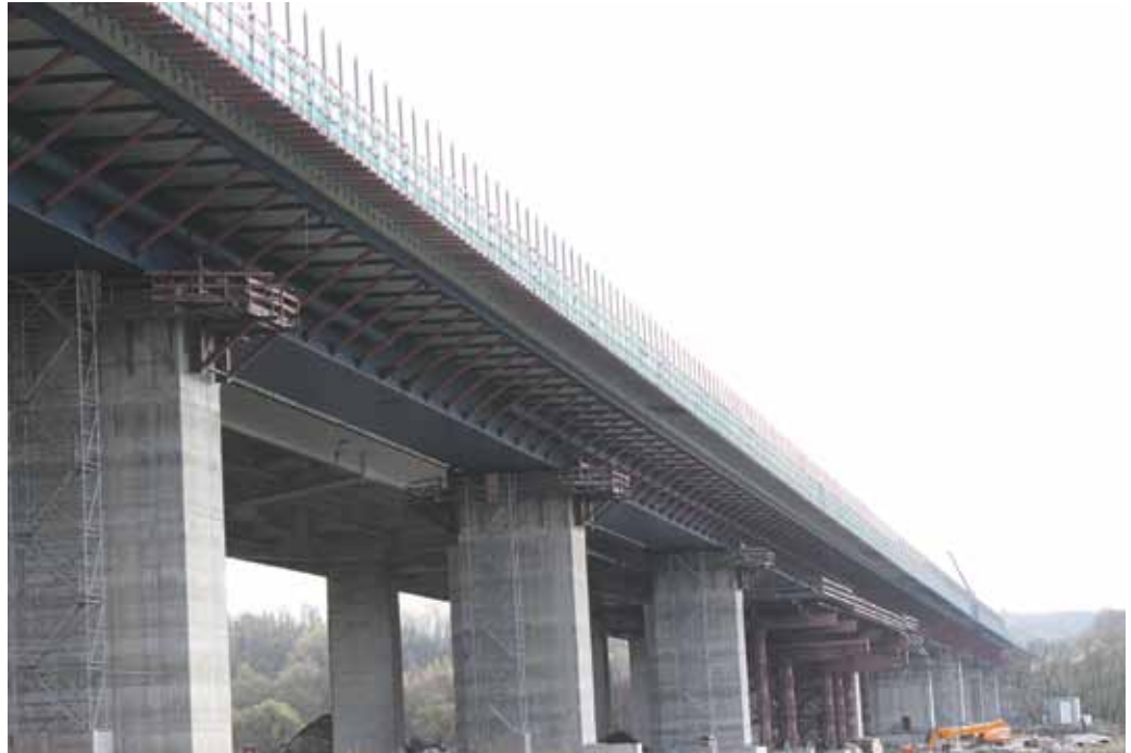
Mittlerweile hat der nächste Bauabschnitt an der Lennetalbrücke begonnen
